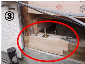
土台が腐食していたので部分交換をし、基礎との引抜け防止金物を付けました。
